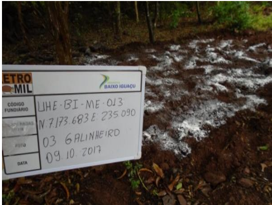
Figura 1.1-1 - Desinfecção de fontes contaminantes.
