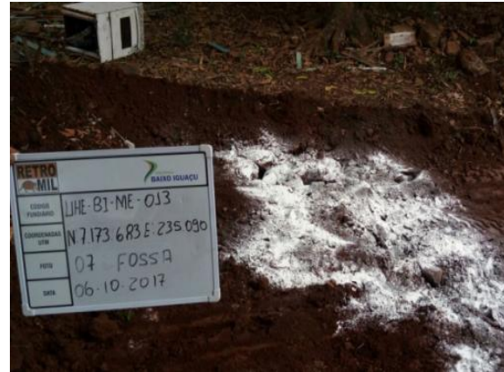
Figura 1.1-2 - Desinfecção de fontes contaminantes.
