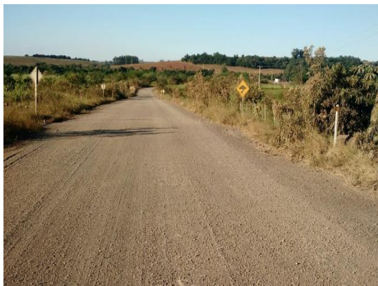
Figura 3.22-8 - Redutor de velocidade.
