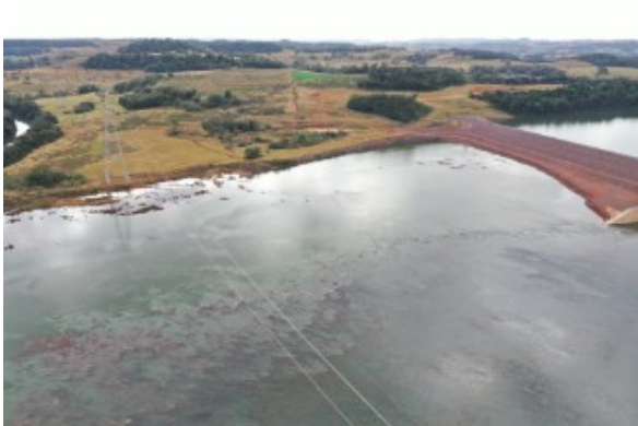
Canteiro de obras – MD - Julho 2019.
