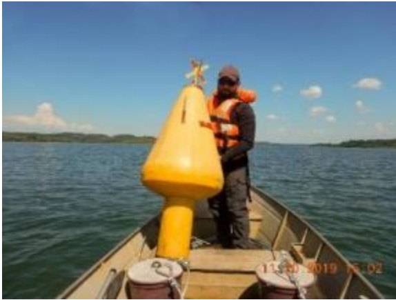
Instalação da estrutura da base de telemetria acústica instalada a montante próximo ao barramento
