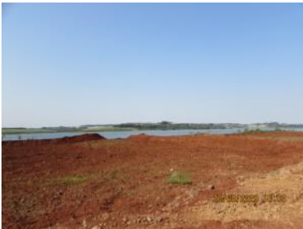
Suavização do terreno e correção do sistema de drenagem.
