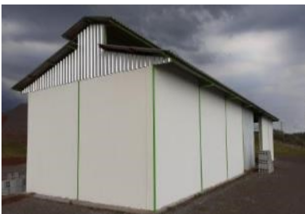
Depósito de Óleo e Resíduos (DOR).
