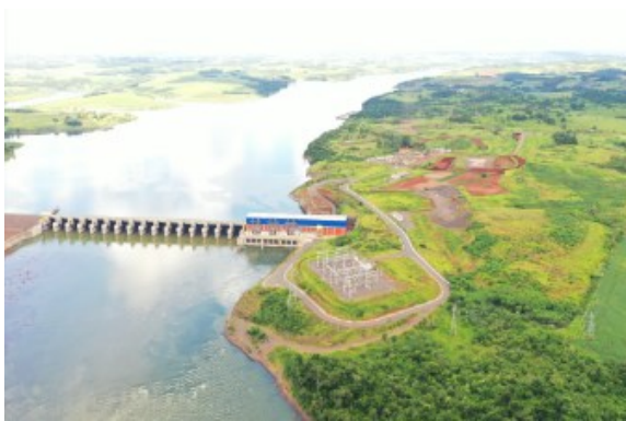
Canteiro de obras – ME – Janeiro 2020.
