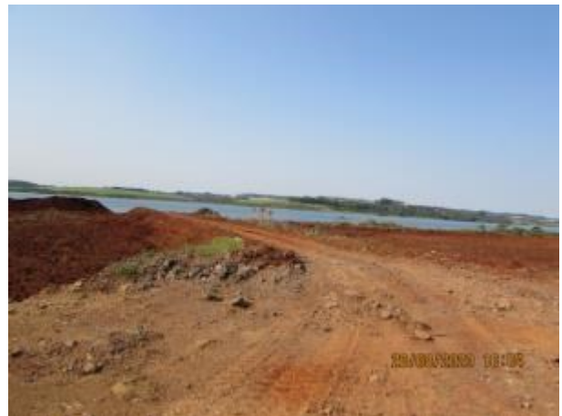
Início da remoção dos taludes das lagoas.
