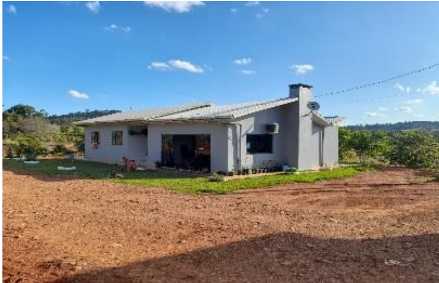
Figura 4-46: Área de Lavoura, pastagem e benfeitorias. Reassentamento rural coletivo. Propriedade de origem ME-018.1 – pequeno proprietário.
