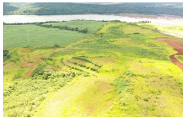
Canteiro de obras – ME - Julho 2020.
