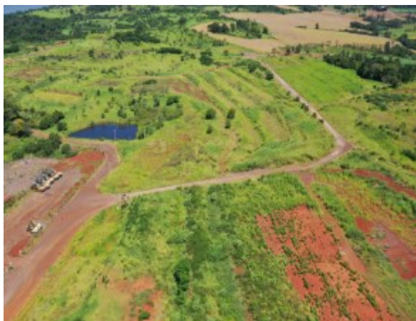
Canteiro de obras – ME - Janeiro 2021.
