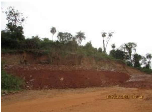
Reconformação do terreno na área do talude do piezômetro.
