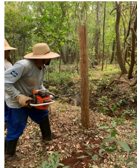
Perfuração de mourão em cerca de mata no remanso do Rio Andrada.
