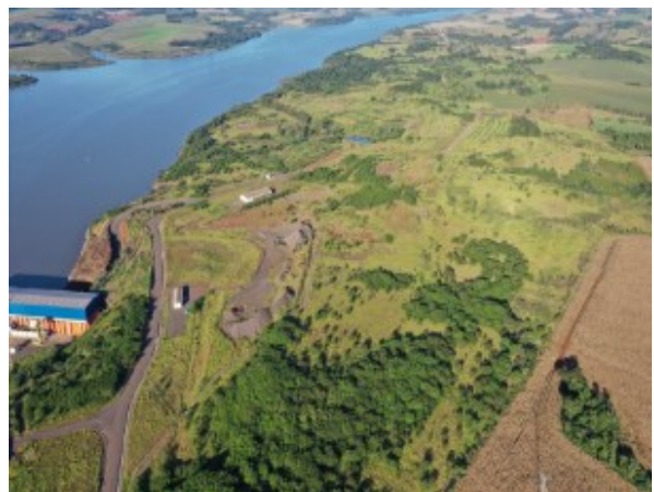
Canteiro de obras – ME - Julho 2022.
