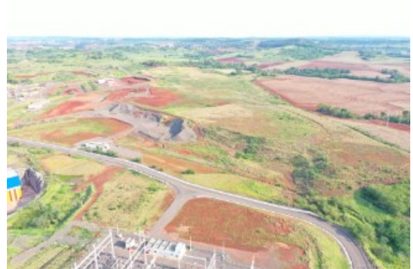
Canteiro de obras – ME - Novembro 2019.
