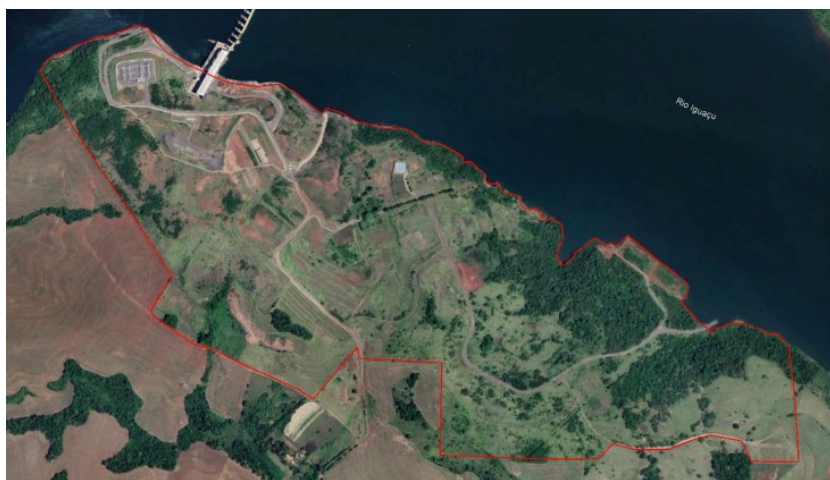
Canteiro de obras, setembro/22.
