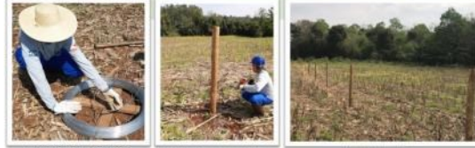
Assim de aço-carbono ovalado e zincado.
