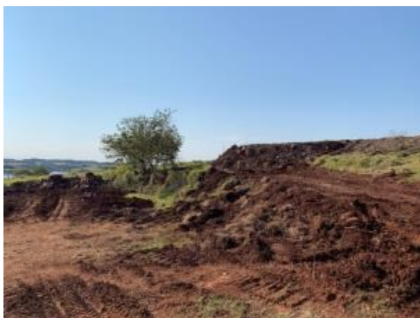
Estrutura de concreto e depósito de cascalho sendo removidos.
