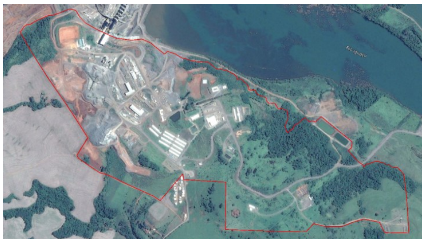
Canteiro de obras, março/17.
