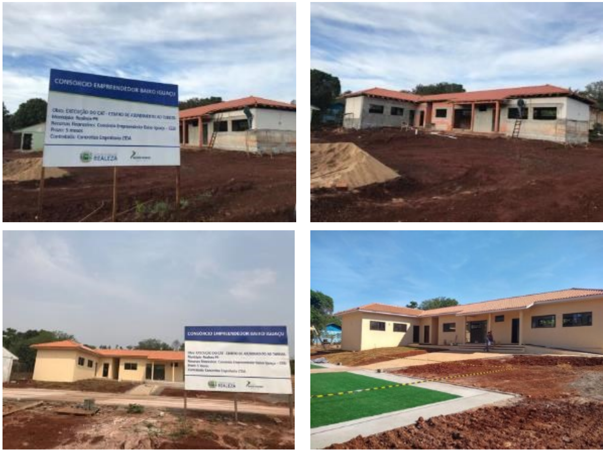
Figura 4-54: Evidências fotográficas da reforma e construção do CAT.
