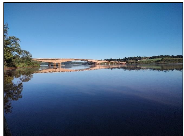
Foto 104 - Reservatório rio Andrada - Tratamento
