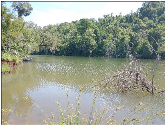
Foto 101 - Reservatório rio Capanema - Tratamento
