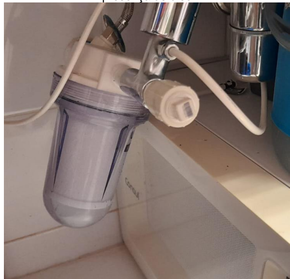
Figura 23 Revisão troca pré-filtro bebedouro
