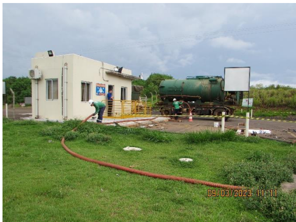
Figura 10 Limpeza sumidouro guarita
