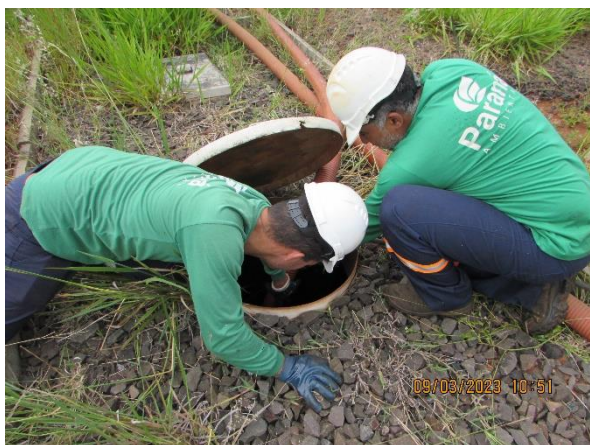
Figura 12 Limpeza ETE subestação
