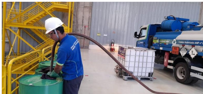
Figura 07 Coleta de óleo contaminado casa de força
