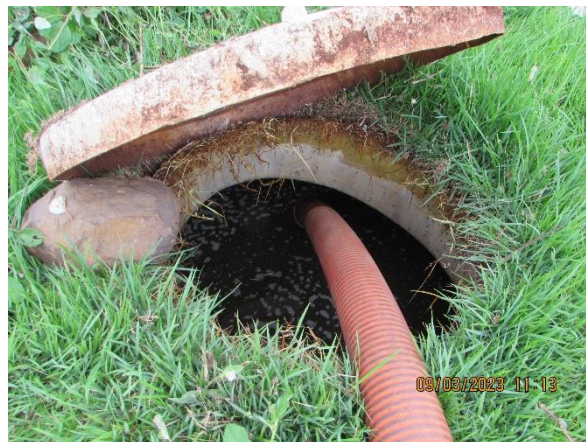
Figura 11 Limpeza sumidouro guarita
