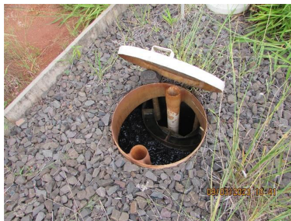
Figura 13 Limpeza ETE subestação
