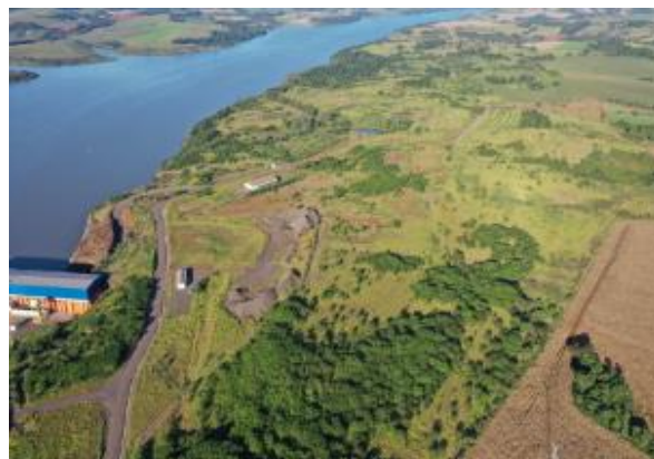
Canteiro de obras – ME - Julho 2022.
