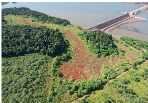
Atividade de gradagem/roçada na área B7S2
