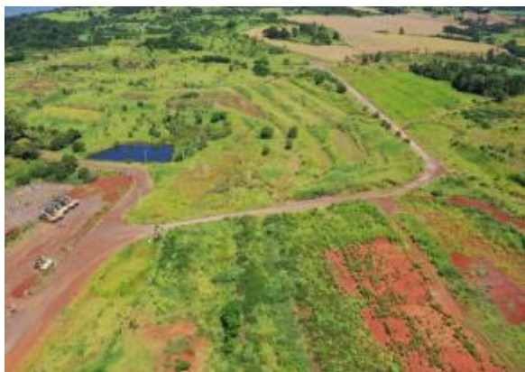
Canteiro de obras – ME - Janeiro 2021.
