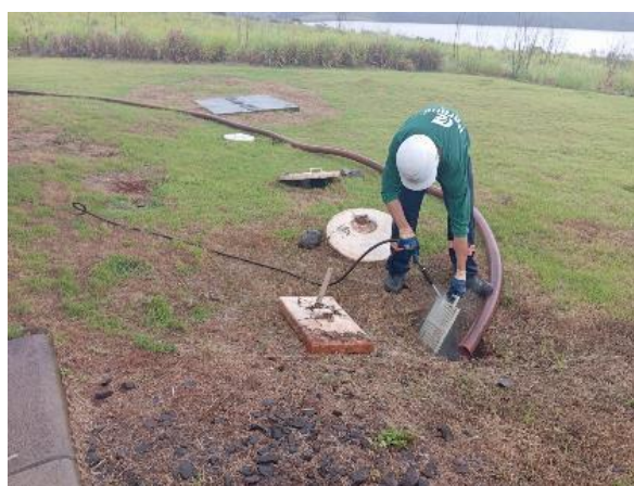
Figura 4-17 - Limpeza gradeamento fino sumidouro guarita
