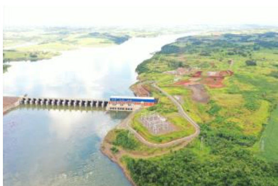
Canteiro de obras – ME – Janeiro 2020.
