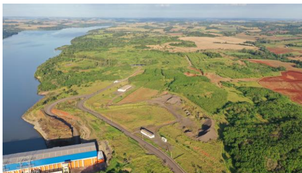
Canteiro de obras – ME - Setembro 2024.
