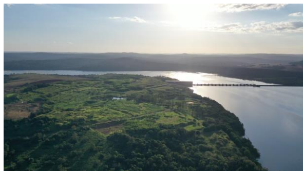
Canteiro de obras – ME - Junho 2024.
