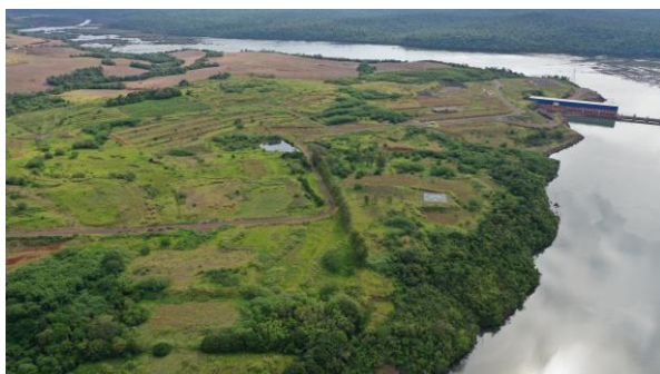
Canteiro de obras – ME - Setembro 2021.
