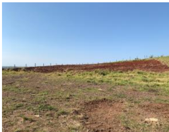
Baia de contenção desmobilizada.
