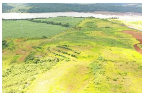
Canteiro de obras – ME - Julho 2020.
