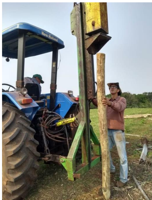
Treinamento com equipamento bate estacas.
