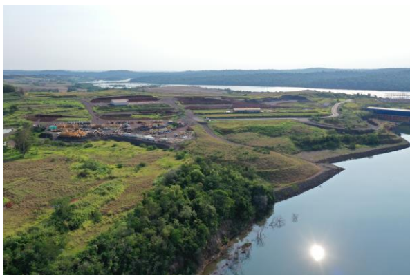
Canteiro de obras – MD - Julho 2019.
