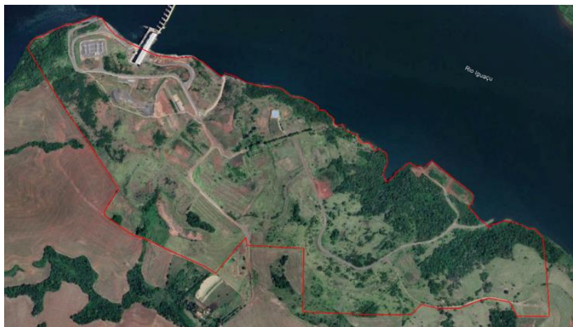
Canteiro de obras, setembro/22.
