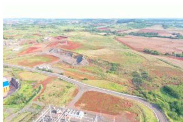
Canteiro de obras – ME - Novembro 2019.
