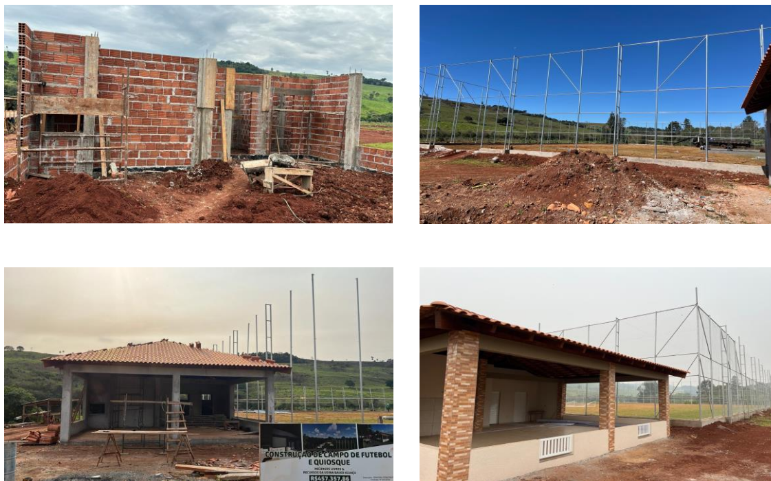
Figura 4-93: Evidências fotográficas da construção do campo de futebol e quiosque.
