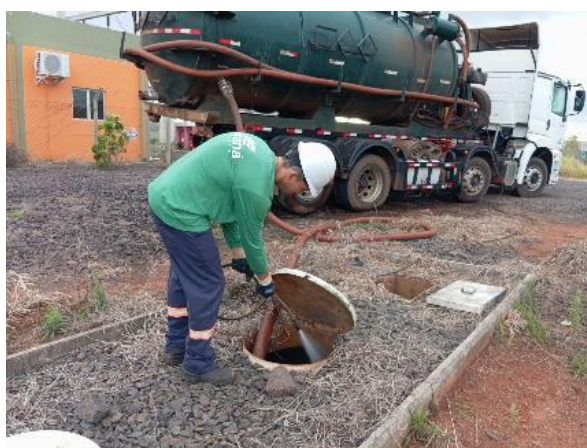
Figura 4-16 - Limpeza sumidouro guarita
