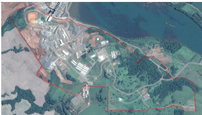
Canteiro de obras, março/17.
