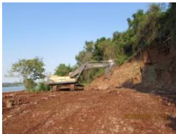
Reconformação do terreno na área do talude do piezômetro.
