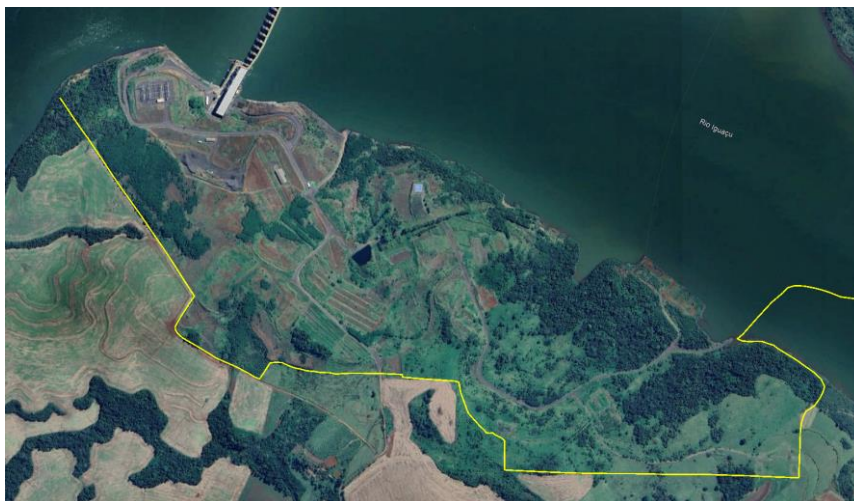
Canteiro de obras, setembro/23.
