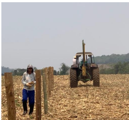
Trator com equipamento bate estaca em cerca de remanso no Rio Cotegipe.
