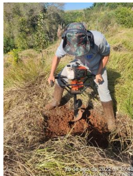
Coveamento semi mecanizado.
