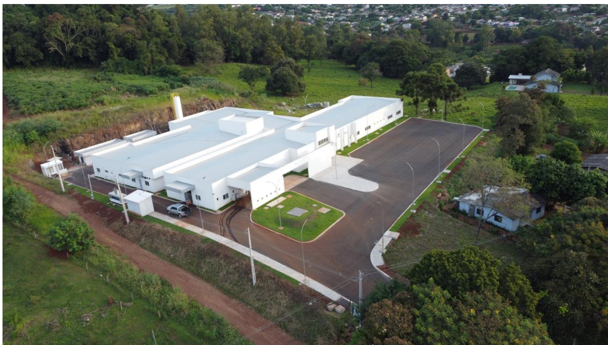
Figura 4-86 – Construção do hospital municipal de Capitão Leônidas Marques
