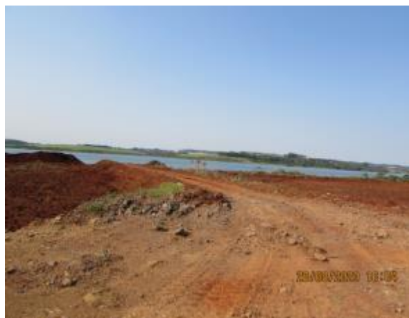
Início da remoção dos taludes das lagoas.
