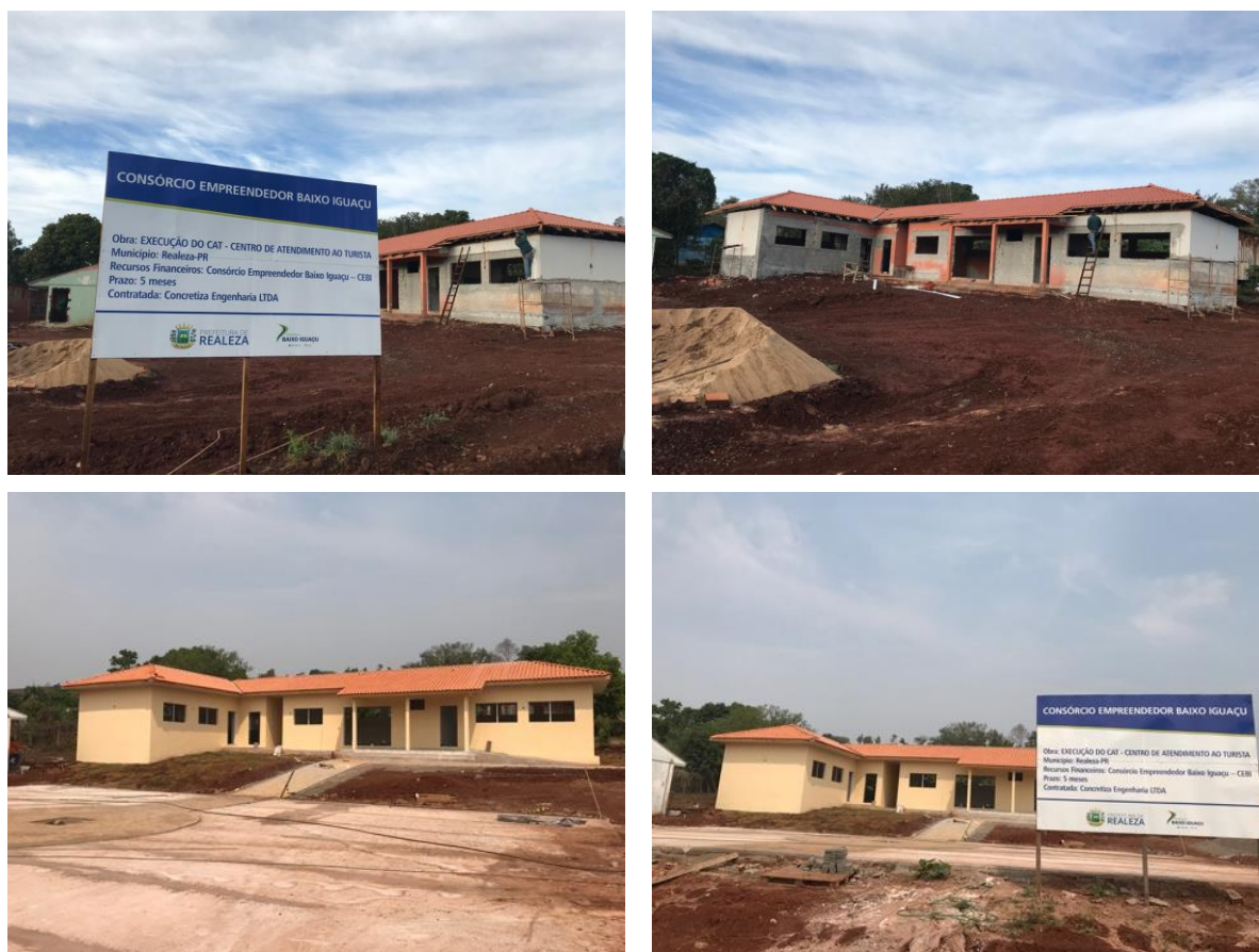
Figura 4-92: Evidências fotográficas da reforma e construção do CAT.
