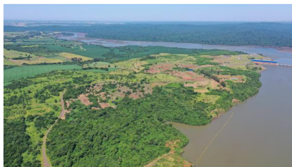
Canteiro de obras – ME - Janeiro 2024.
