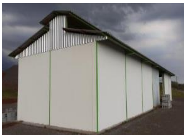
Depósito de Óleo e Resíduos (DOR).
