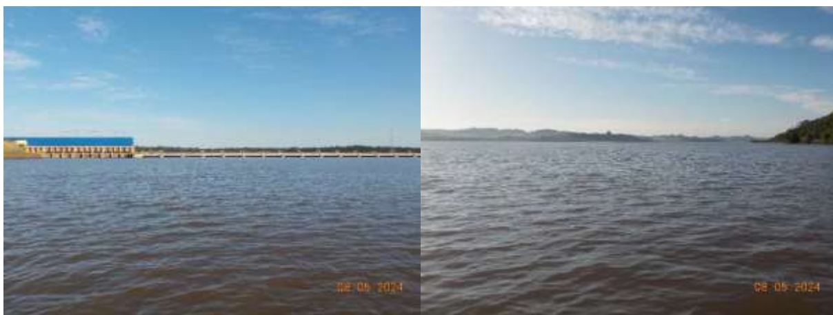
Figura 4 - Vista Panorâmica do local IGUABAIXO (13).
