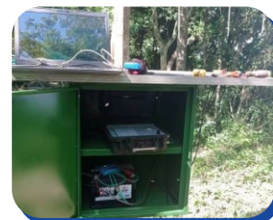
Instalação de nova base de radiotelemetria na zona 8.
