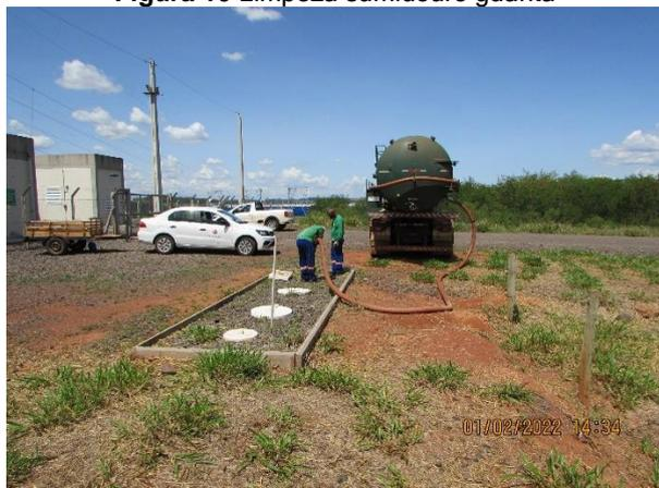
**Figura 12** Limpeza ETE subestação
