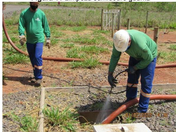
**Figura 13** Limpeza ETE subestação
