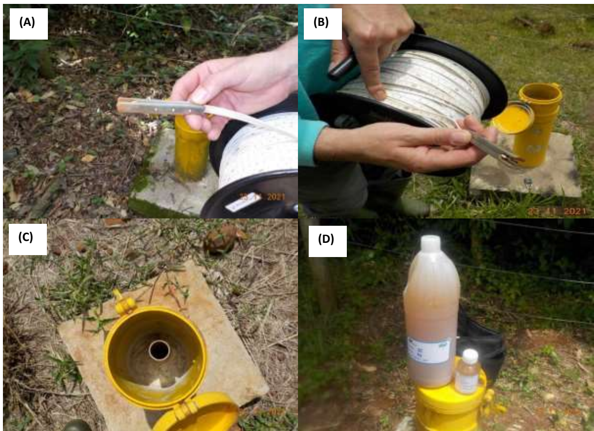
Figura 25 – Medição do nível do freático realizada no poço 2B (A), 6A (B) demonstrando o sedimento no sensor da trena, poço 5A (C) com pedra no cano e poço 5C (D) presença de sedimento na água.
