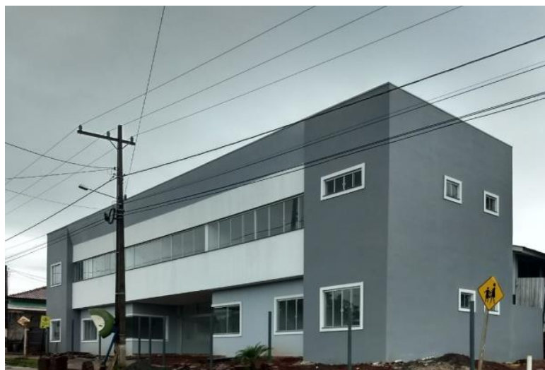
Ampliação da Escola Municipal Santa Mônica – Capitão Leônidas Marques.
