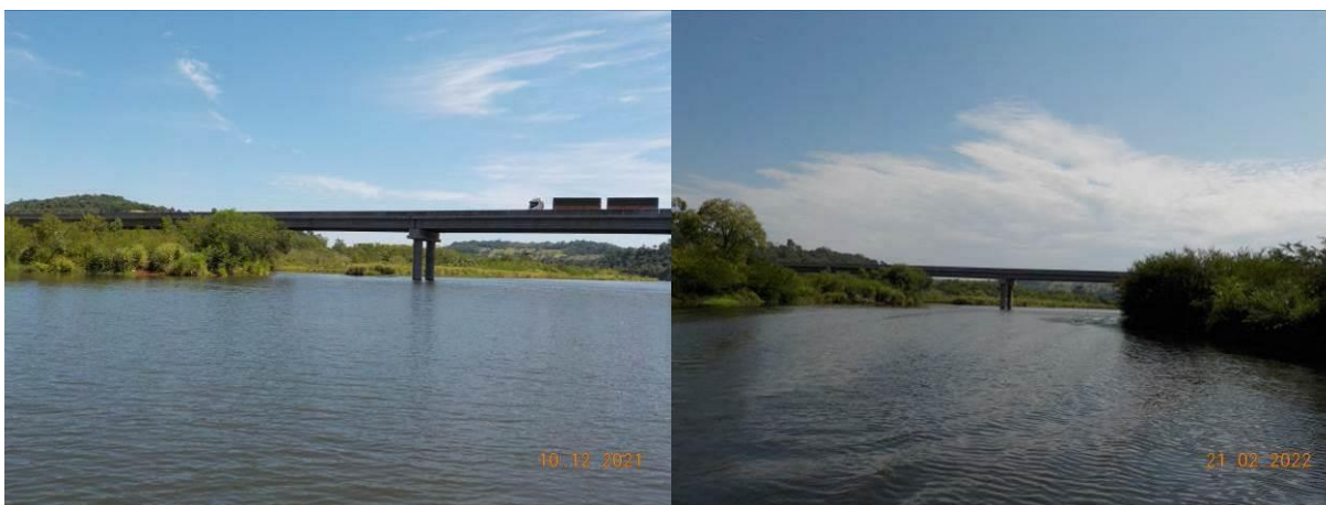
Figura 3.6 - Vista Panorâmica do ponto de amostragem do rio Andrade, local ANDRAMED (7).
