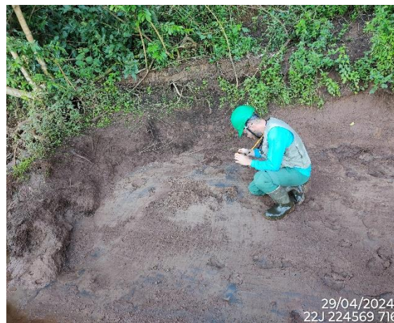
Foto 26. Vistoria em margens.
