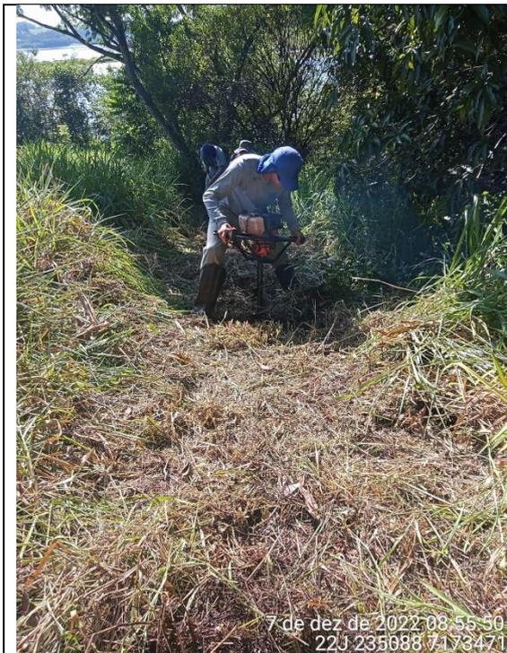
**Figura 23: Abertura de cova sendo realizada com o perfurador.**
