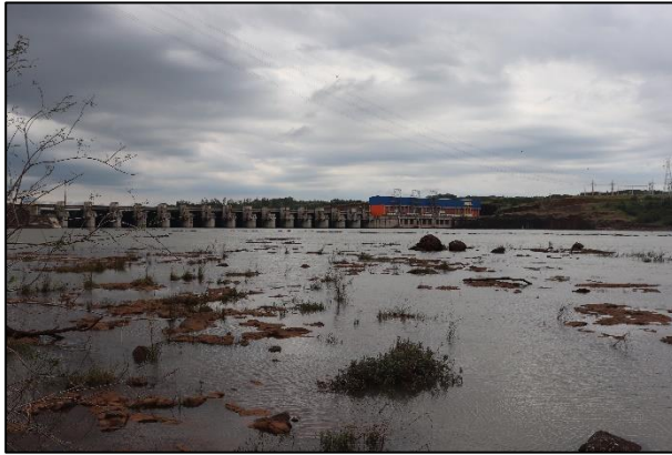
Foto 75 - Área de amostragem por redes-feiticeira ( trammel nets ) a montante da UHE Baixo Iguaçu (Trecho 1c - Controle).
