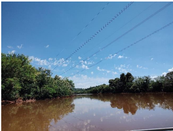
Foto 91 - Reservatório rio Capanema - Tratamento
