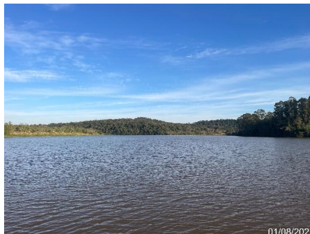
Vista de Jusante
