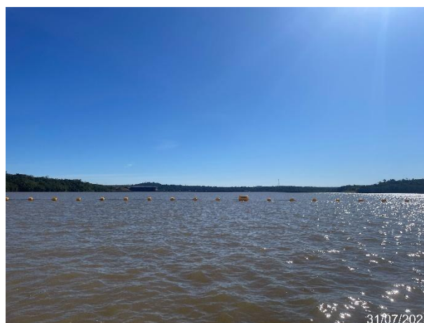
Vista de Jusante
