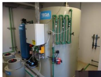
Estação compacta de tratamento de água UHE Baixo Iguaçu
