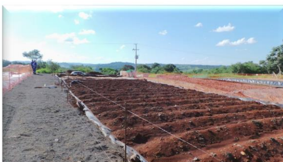
Tratamento do solo contaminado por biorremediação
