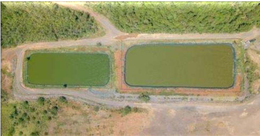
Estação de Tratamento de Efluentes – ETE (ME) 2019.
