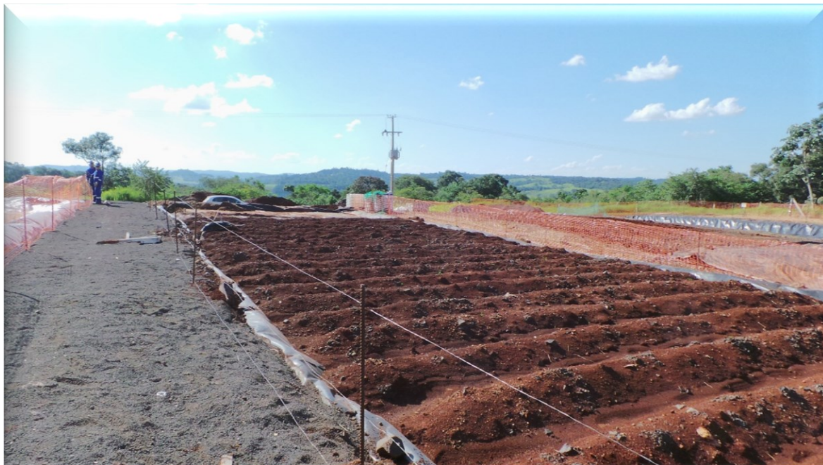
Tratamento do solo contaminado por biorremediação
