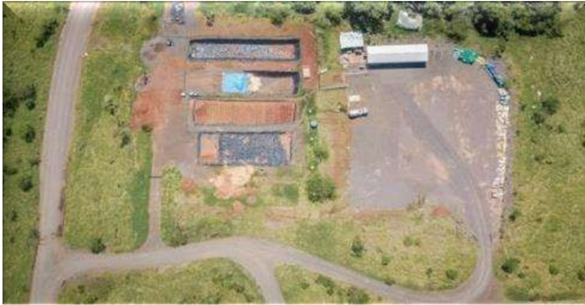
Durante a construção aterro sanitário da UHE
