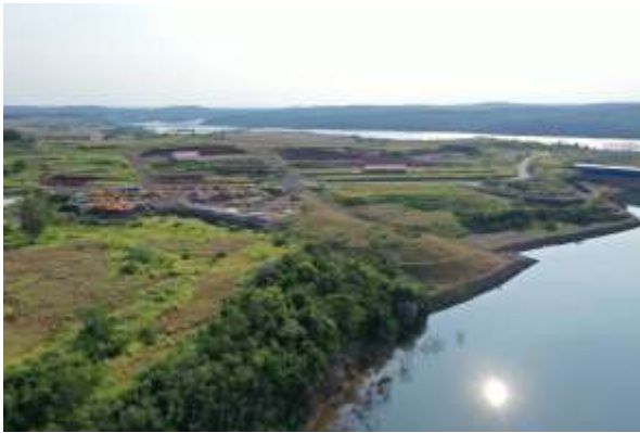
Canteiro de obras – MD - Julho 2019.
