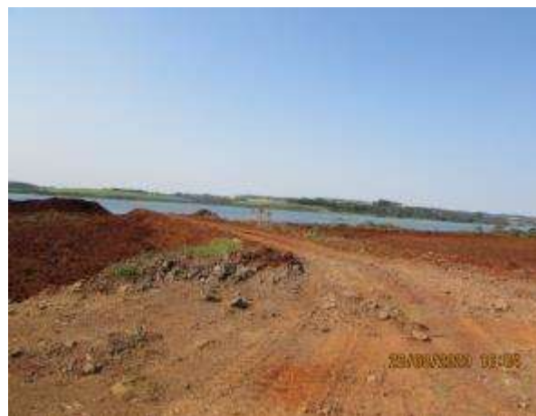
Início da remoção dos taludes das lagoas.
