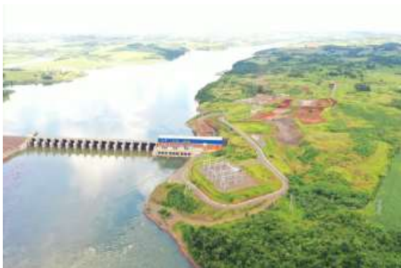
Canteiro de obras – ME – Janeiro 2020.
