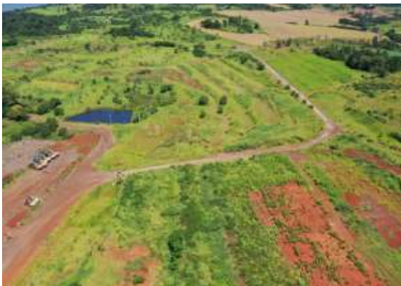
Canteiro de obras – ME - Janeiro 2021.
