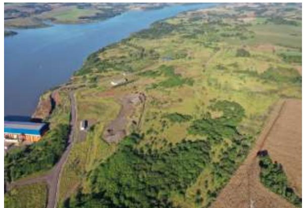
Canteiro de obras – ME - Julho 2022.
