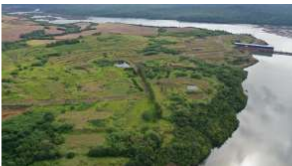
Canteiro de obras – ME - Setembro 2021.
