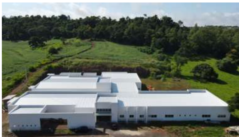
Figura 50 – Construção do hospital municipal de Capitão Leônidas Marques
