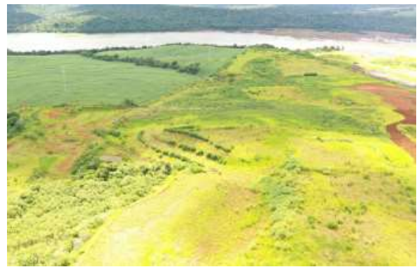
Canteiro de obras – ME - Julho 2020.
