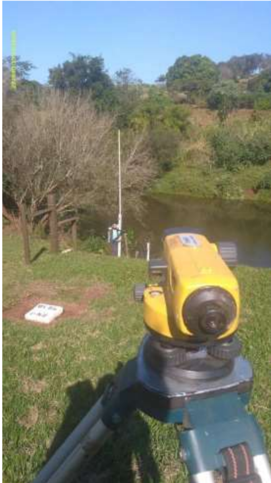
Nivelamento realizado na Estação UHE Baixo Iguaçu Rio Andrada – 19/05/2020.
