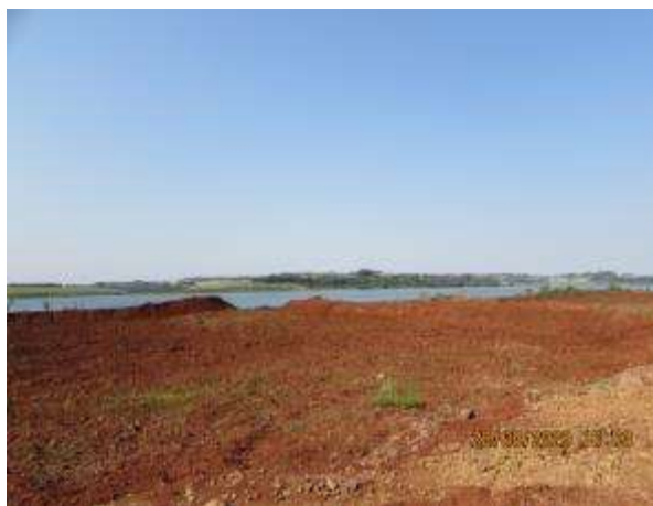
Suavização do terreno e correção do sistema de drenagem.
