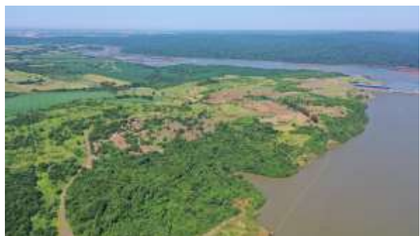
Canteiro de obras – ME - Janeiro 2024.
