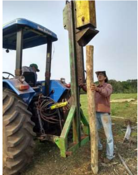
Treinamento com equipamento bate estacas.
