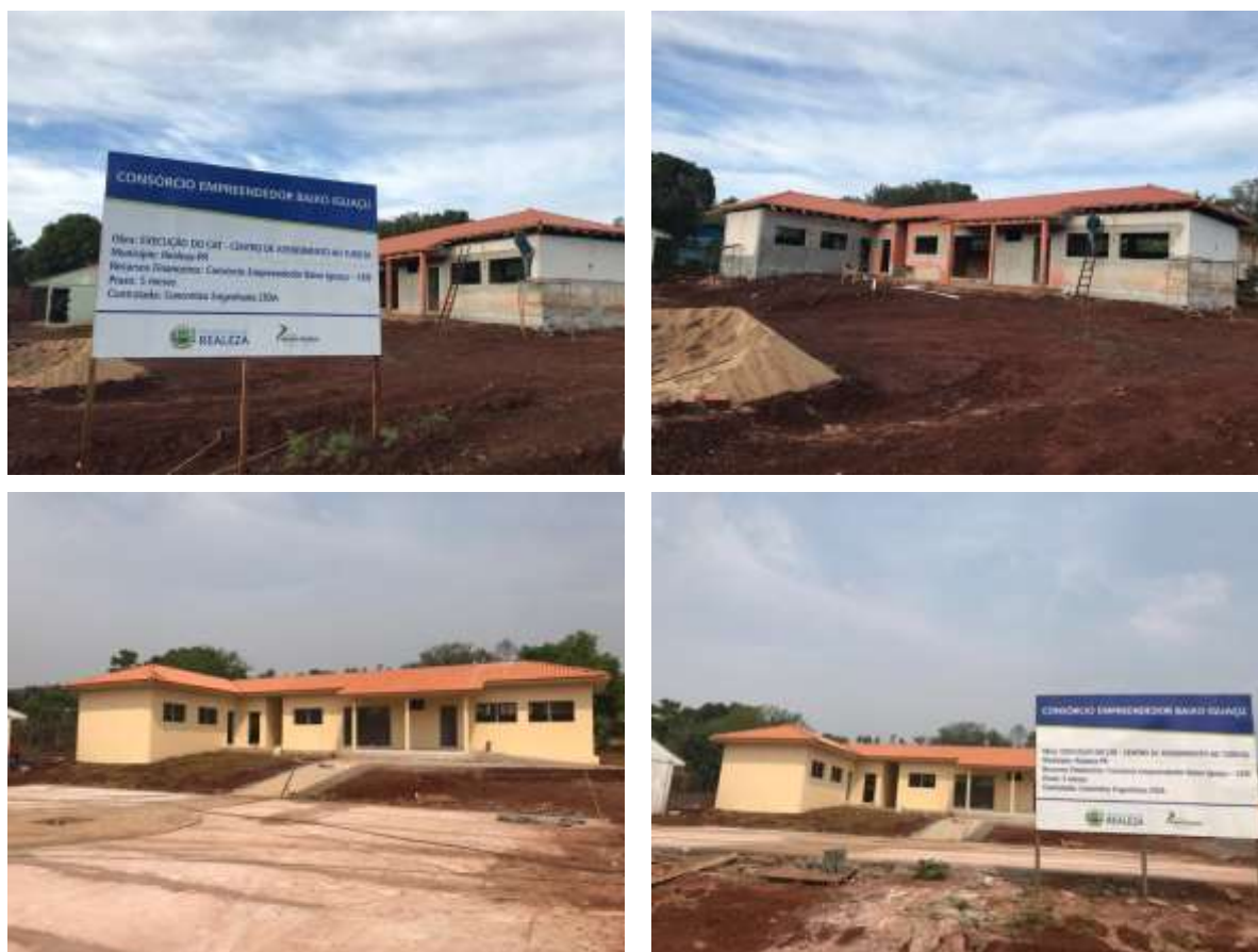
Figura 4-56: Evidências fotográficas da reforma e construção do CAT.
