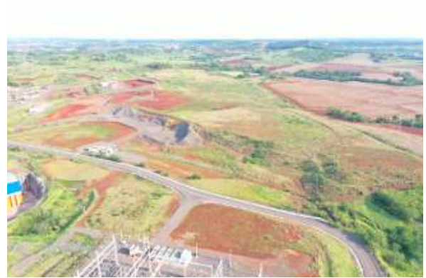
Canteiro de obras – ME - Novembro 2019.
