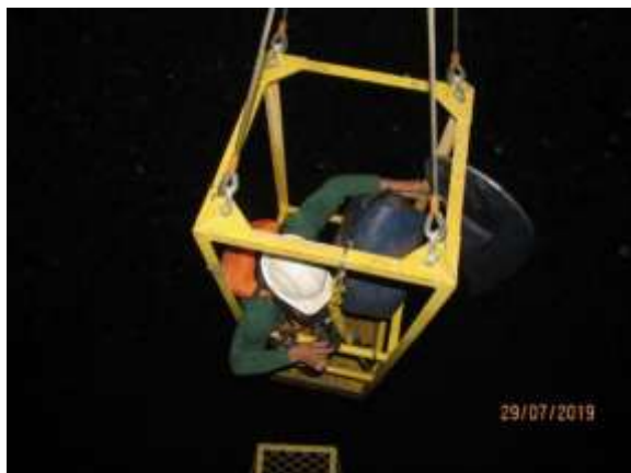
Descida da equipe no interior do tubo de sucção da UG-01 para as atividades de resgate de ictiofauna, julho de 2019.
