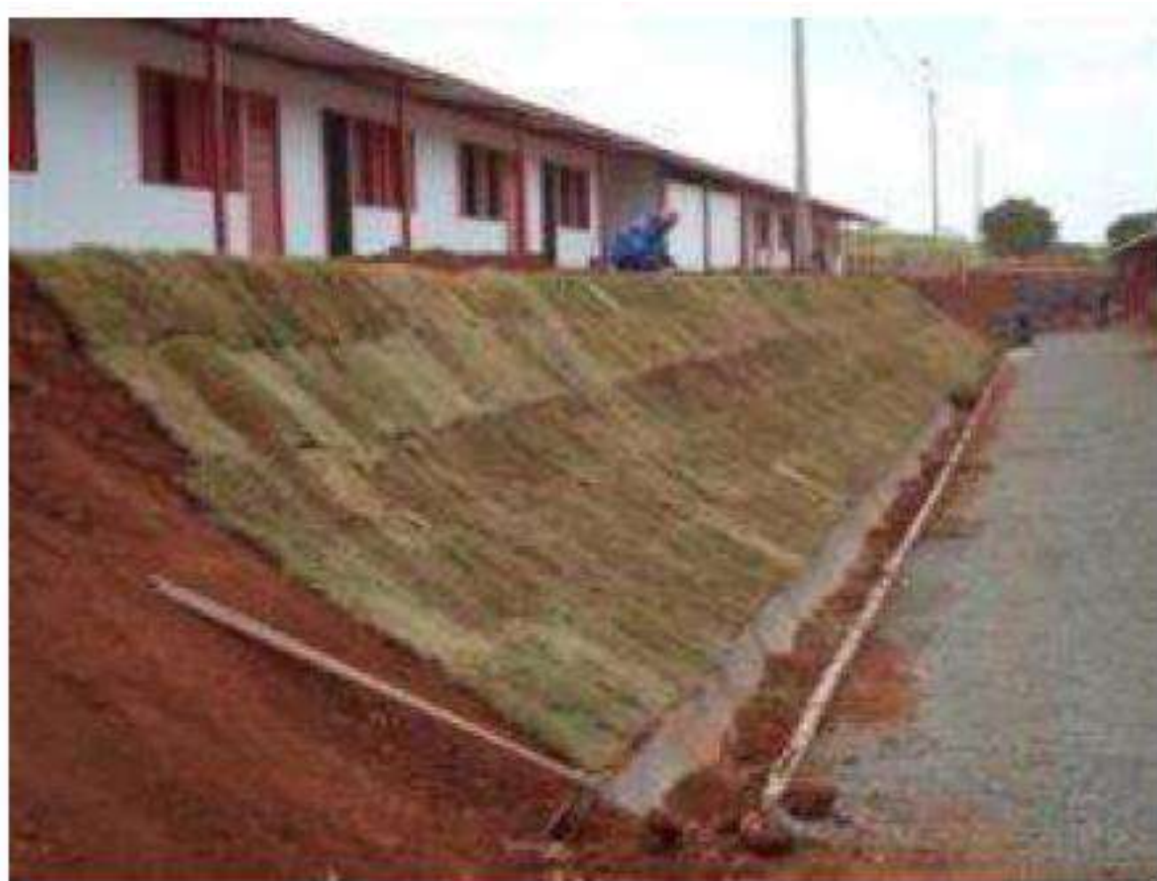
Figura 10 - Proteção de taludes em áreas de alojamento.
