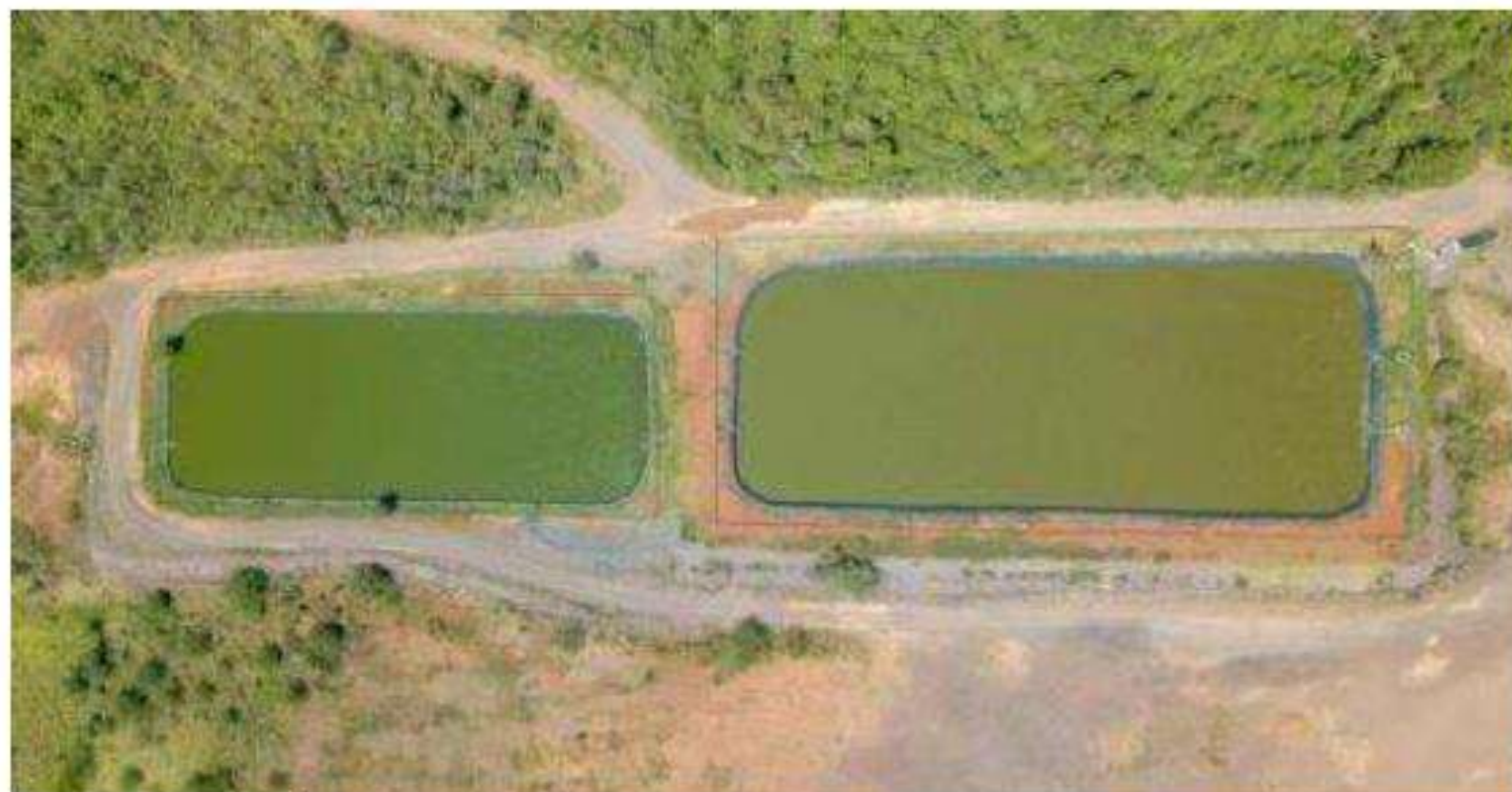
Figura 36 - Estação de Tratamento de Efluentes – ETE (ME).
