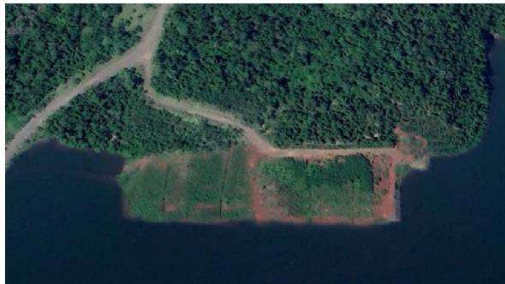
Figura 37- Estação de Tratamento de Efluentes – ETE (ME) 2022.
