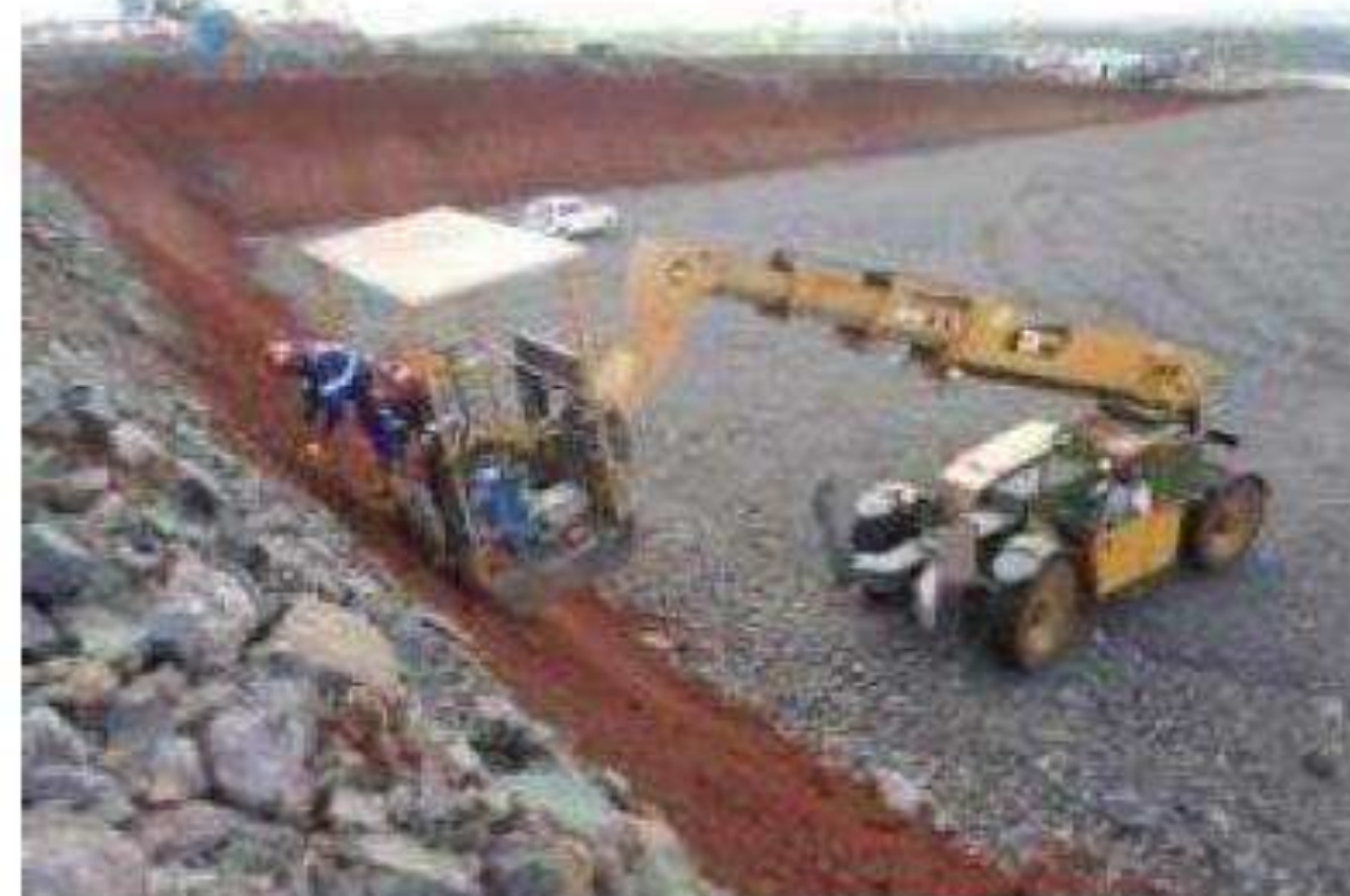
Figura 12 - Plantio de gramíneas para proteção dos taludes na área dos pátios.
