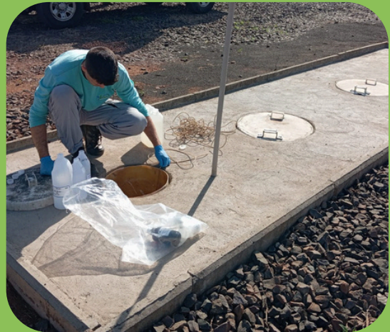
Monitoramento do efluente sanitário tratado na ETE da UHE Baixo Iguaçu
